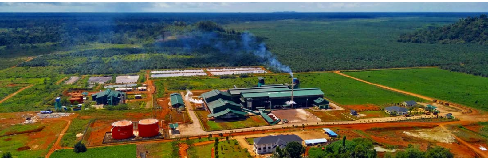
Pabrik Kelapa Sawit di PT KAL, Ketapang, Kalimantan Barat Foto: Corporate Communications
